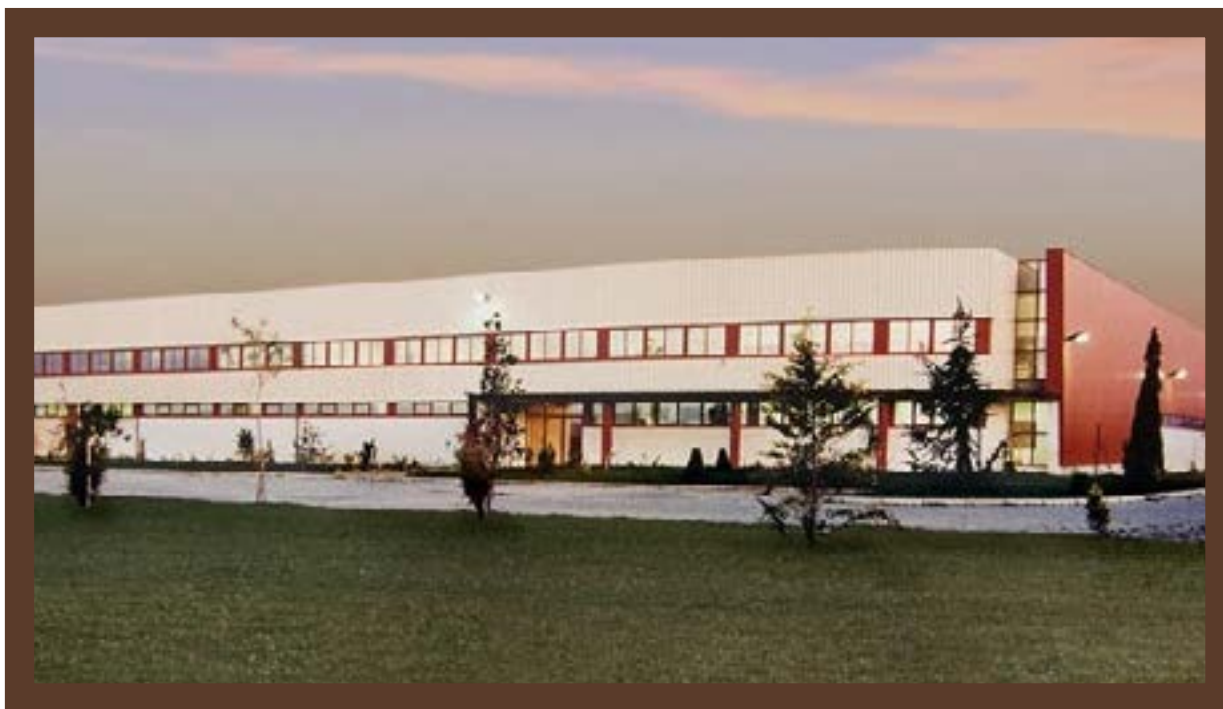
4. Novas instalações, 1995 New facilities, 1995
