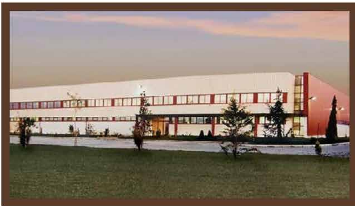
4. Novas instalações, 1995 New facilities, 1995
